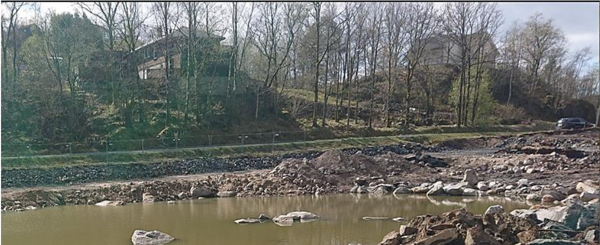
Figur 22: Nærliggende boliger på motsatt side av fylkesvegen. Foto: Torhild Hessevik Eikeland
